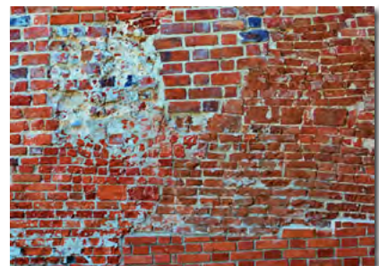
Przemurowanie kamieniem ceglanej ściany w kościele pw. Podwyższenia Świętego Krzyża
