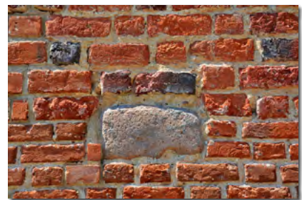
„Dzkie” połączenia cegieł wmurowywanych w ściany kościółka podczas kolejnych etapów jego rozbudowy
