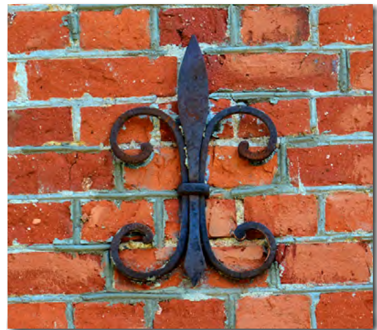
Zbliżenie na kotwę w murze
