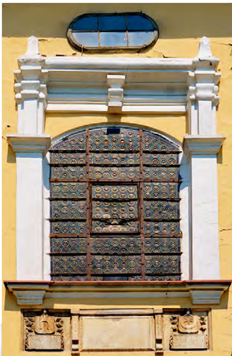
Charakterystyczne zwieńczenie okna w ścianie kaplicy Matki Boskiej Różańcowej
