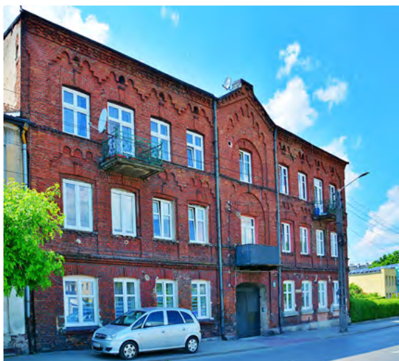
Kamienica o niebanalnym ceglanym detalu, widok ogólny
