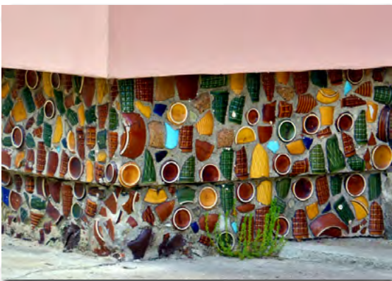
Cokół budynku obłożony stłuczka ceramiczną
