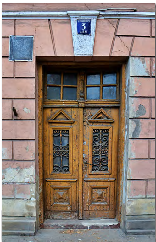
Ozdobne dwuskrzydłowe drzwi prowadzące do sieni i klatki schodowej
