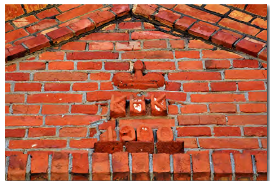
Zbliżenie na ceglany detal na elewacji
