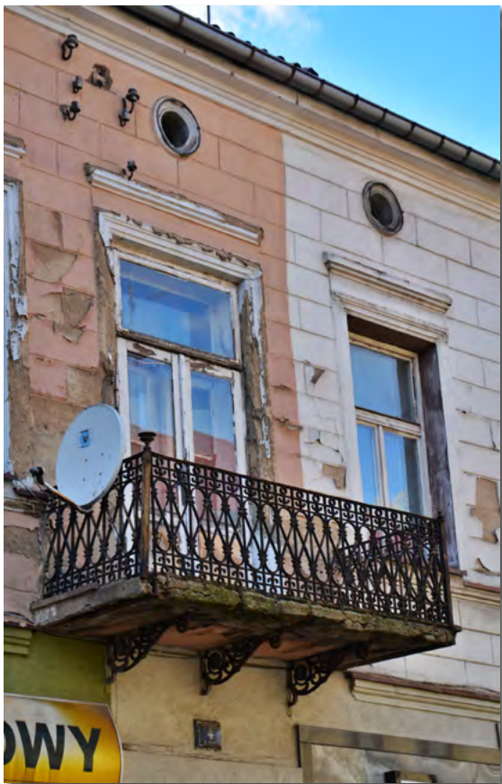
Żeliwny balkon na wspornikach przy ul. Śląskiej 4
