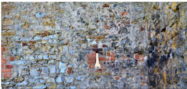
Szczegóły wykończenia murów obronnych Wielunia
