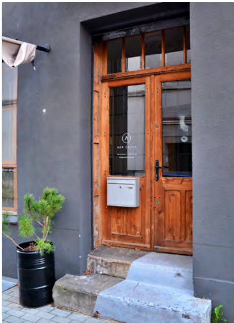
Zbliżenie na detale drzwi domu przy ul. Śląskiej 4
