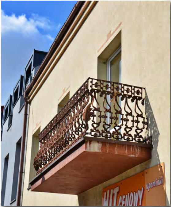
Żeliwny balkon przy ul. Kaliskiej 6
