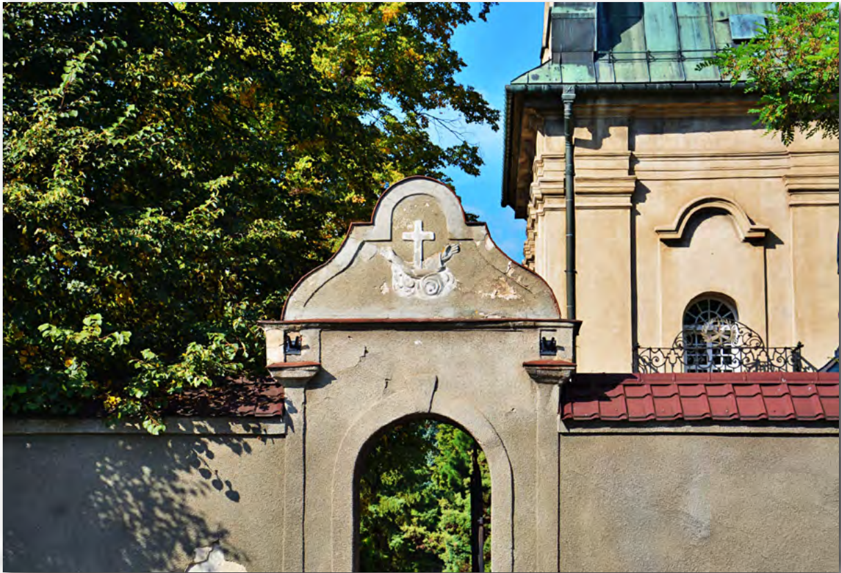
Ogrodzenie kościoła przy ul. Reformackiej, naczółek z emblematem franciszkanów
