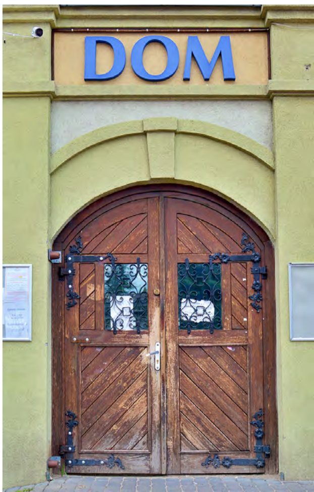
Dom handlowy, zbliżenie na główne wejście
