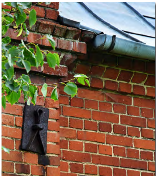
Kaplica św. Rocha, kotwa spinająca narożnik budynku
