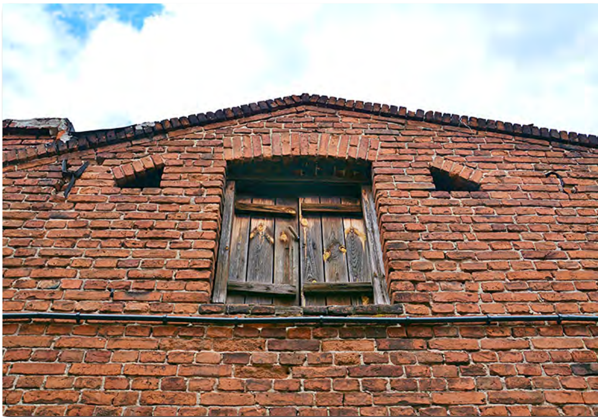
Nadrzeczna 2, zbliżenie na rozwiązania murarskie zastosowane na poddaszu
